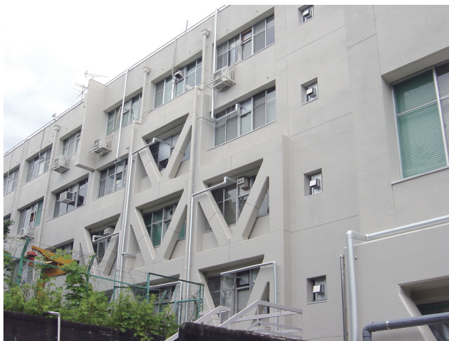
写真 5：耐震補強された外壁
