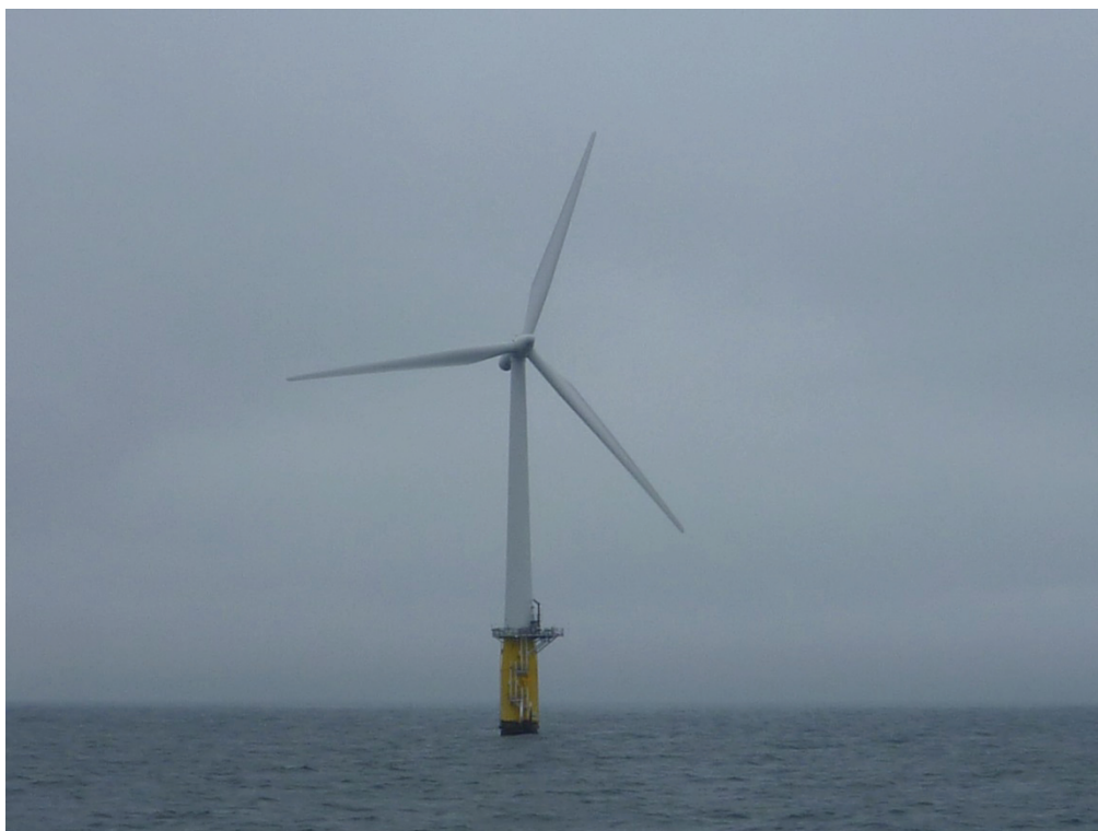
写真 2. Statoil の浮体式洋上風車 Hywind
